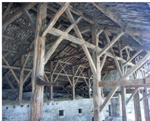
La charpente à «trois nefs» de la Grande grange du Domaine est l'une des trois dernières en Dauphiné ! Elle a subi les outrages du temps. Il sera bientôt trop tard pour la sauver !
